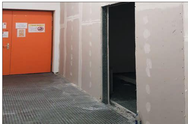
BRANDSCHUTZ ist das A und O: Im Vorraum der Hallen 6,7 und 8 wurde ein weiterer Lagerraum abgemauert, damit Schränke, Regale und Sport-Utensilien sicher deponiert werden können.
