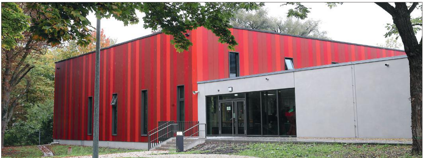
EIN ECHTES SCHMUCKKÄSTCHEN: die neue Gerätturnhalle der TG Landshut.
